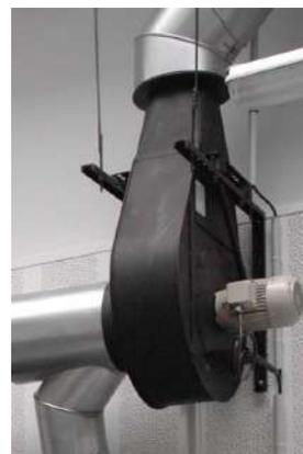
Ventilateur d'aspiration. Fixation sur la hotte ou au mur. Diamètre de sortie : 250 mm.
